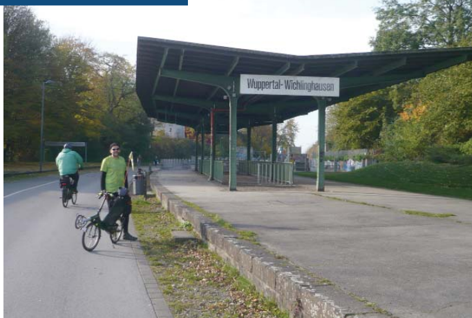
Bahnhof Wichlinghausen an der Nordbahntrasse Wuppertal / Foto: Hanna Brunkhorst
